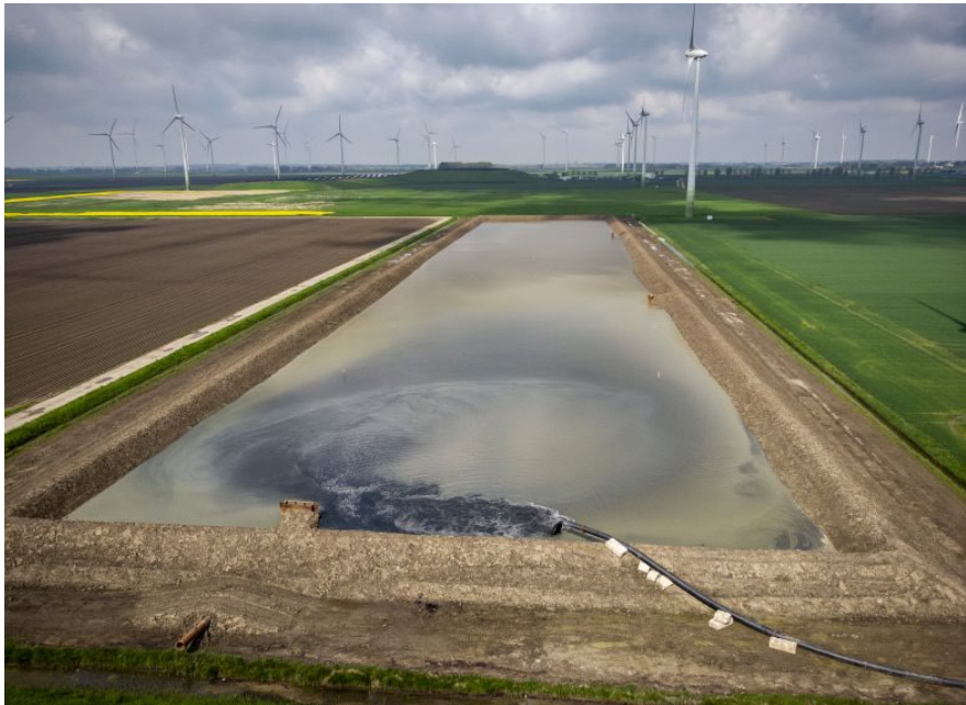
Figuur 10. Pilot ophogen landbouwgrond met slib uit de Eems Dollard 1.
