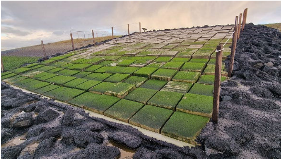
Figuur 19. Van bagger naar Bouwblok, Geowall zetsteen gebruikt als keermuur (Foto: Netics).
