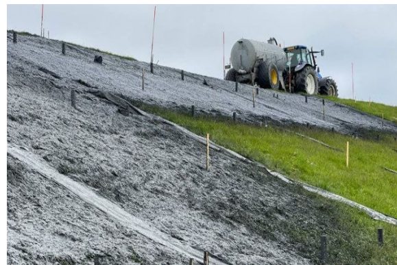
Figuur 25. Schematisch overzicht van de Meegroeidijk (links), waarin de dijk, de anti-piping berm en de kweldijk worden geïllustreerd die geleidelijk groeien door herhaaldelijke toepassing van dunne lagen baggermateriaal (rechts), dat direct op de dijk rijpt tot klei (Fotos: EcoShape, 2021 en Doornebal et al., 2023).
