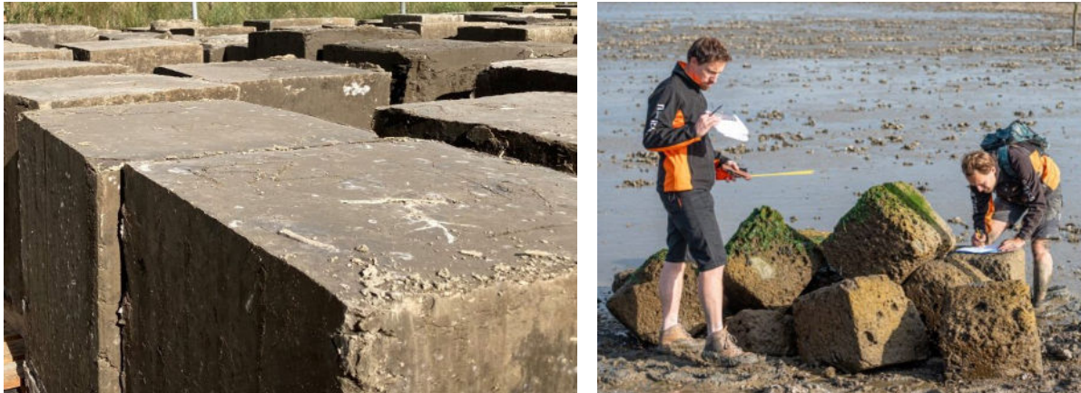
Figuur 18. Rifblokken bij Chemport Innovation Centre (links) en inspectie van rifblokken op het Wad (rechts), (Foto: eemsdollar2050.nl).
